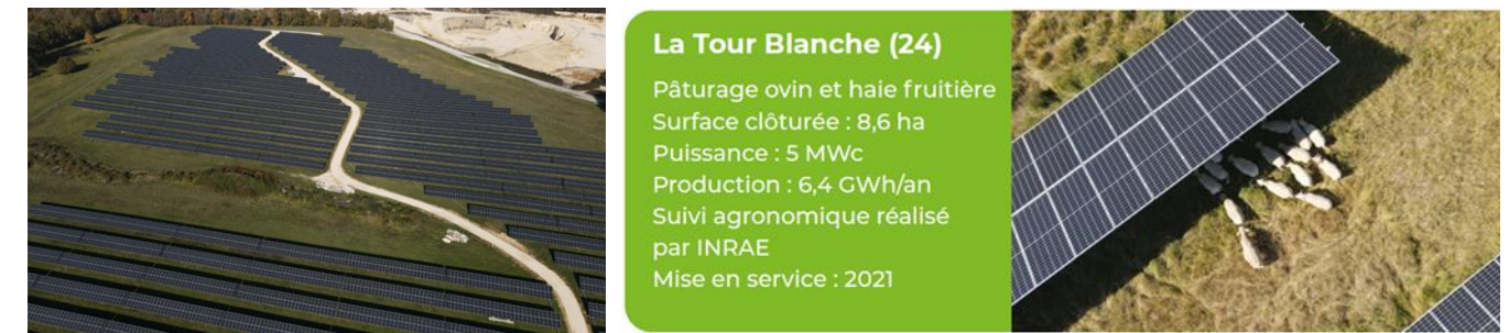
Photo 2 : Parc de la Tour Blanche (24) – (Source : Valorem)
